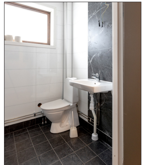
WC/dusch på övervåningen
